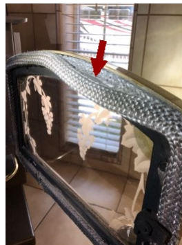
Deficient wood stove door gasket
