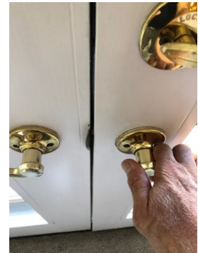
Deficient door latch
