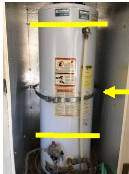
Deficient strapping
