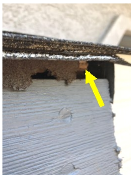
Missing edge flashing
