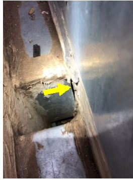
Deficient plenum seal
