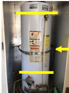
Deficient strapping
